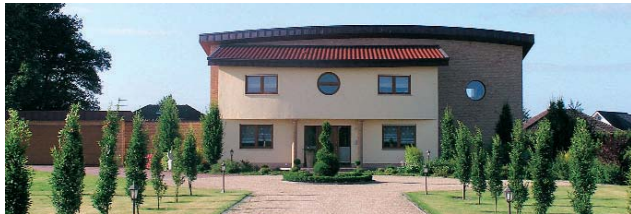
Wärmedämmverbundsystem, kombiniert mit Verblendmauerwerk
