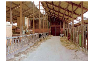
Halle aus Holzständerwerk
