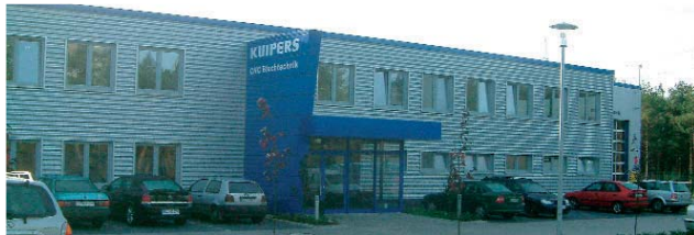
Bürotrakt in Massivbauweise
