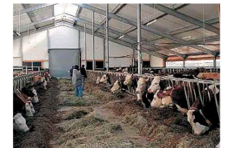
Halle in Stahlbauweise
