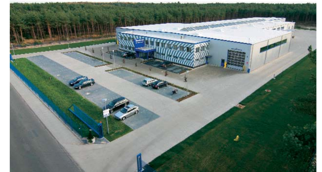
Pflasterarbeiten, Außenanlagen, Entwässerung, Kuipers in Meppen
