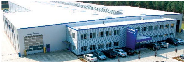
Rohbau und Außenanlagen
