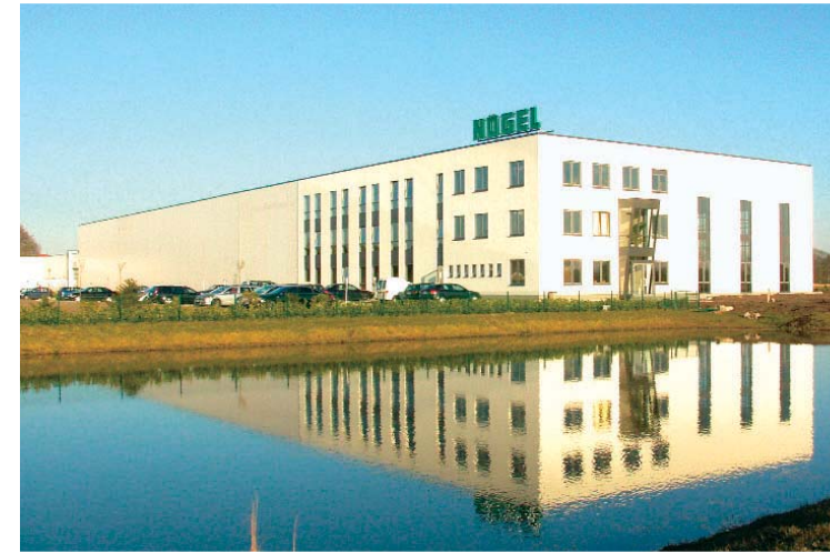
Verwaltung: Massivbauweise mit WDVS, Lager: Stahlhalle in Sandwichbauweise
