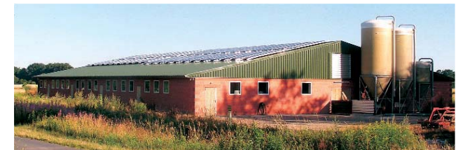
Außenwände: Poroton, Innenwände: KS, Dach: Nagelplattenbinder
