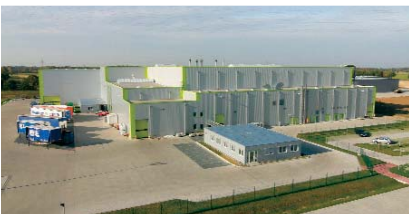
Rohbau und Außenanlagen
