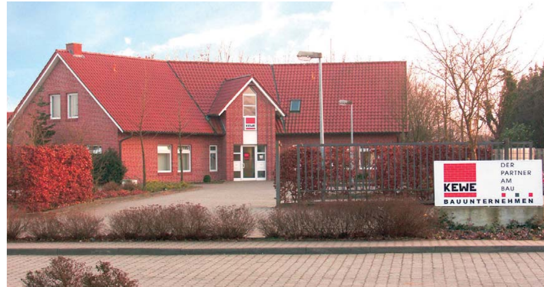
Verwaltungsgebäude der Firma KEWE
